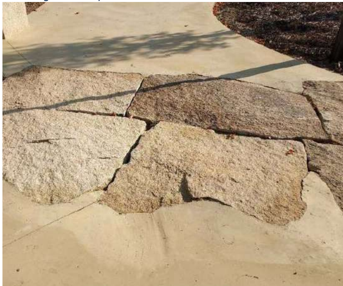
Dalle de granit rose posée sur le béton lisse couleur sable
