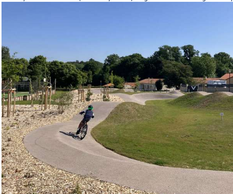
Le Pumptrack sur-mesure (enrobé + pelouse) longeant la butte bocagère et la pente générale existante
